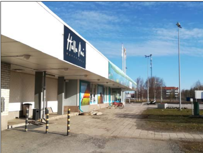
Aikakaudelle tyypillinen paksu räystääs toimii myös katoksena.
