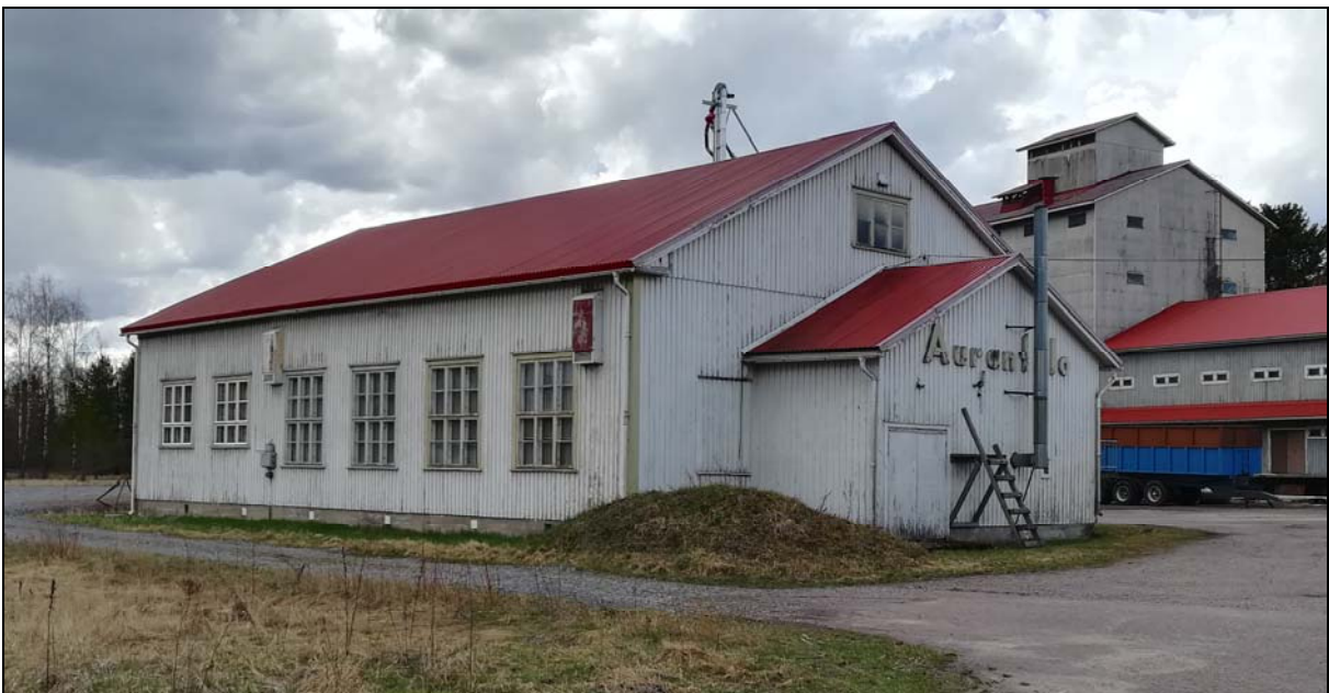
Aurantalolle kuljetaan Oikokujan suunnasta. Rakennus sijaitsee samassa pihassa viljavaraston kanssa.
