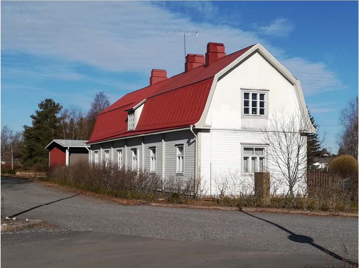
Kauniston kiinteistön entinen kaupparakennus (1) sijaitsee rautatieasemalle johtaneen raitin, nykyisen Oikokujan varrella. Rakennus on säilynyt pääpiirteissään rakentamisaikansa asussa. Katujulkisivun puolella ollut myymälän sisäänkäynti on poistettu ja korvattu kolmella ikkunalla, jotka ovat muiden kanssa samaa tyyliä.
