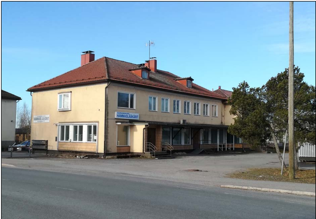
Säästöpankin entisen toimitalon (3) pääty suuntautuu Turuntietä kohti ja katujulkisivu sisäänkäynteineen Poikkikujalle. Etualan vanhempi 1950-luvun alun rakennusosa ja laajennus ovat samantyyllisiä, molemmat ovat rappauspintaisia ja aumakattoisia. Aikakaudelle tyypillisinä tehokeinoina on käytetty laatoituksia ja katosnauhaa.
