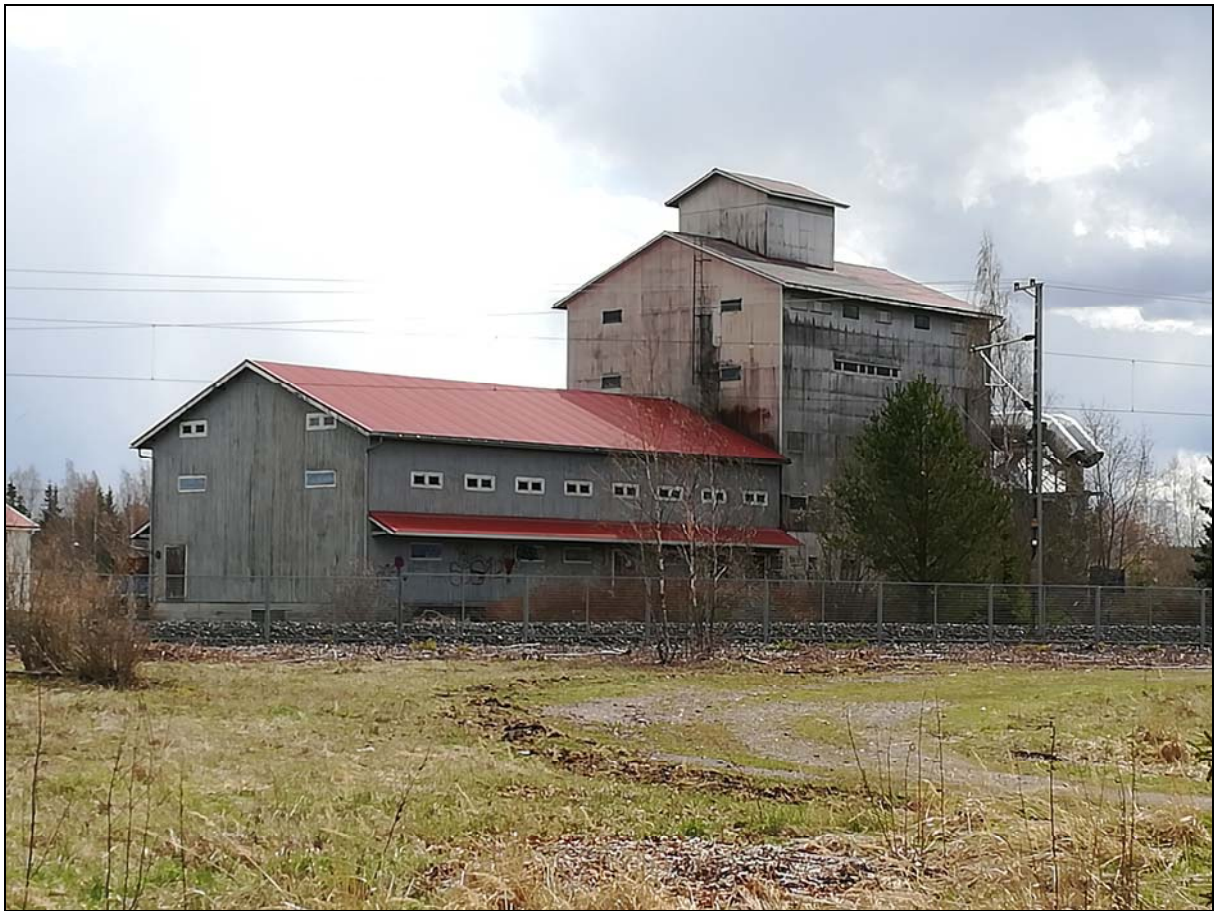
Vanha viljavarasto on laajalle näkyvä ja taajamakuvaan vaikuttava maamerkki. Puurunkoisen rakennuksen matalammassa osassa sijaitsivat myymälä ja varastotilat. Korkeampi osa sisältää viljankuivaamon, jonka elevaattorille on tehty torni harjakaton yläpuolelle. Rakennuksen vierellä kulki tavaroiden ja viljan lastaamisessa käytetty pistoraide.
