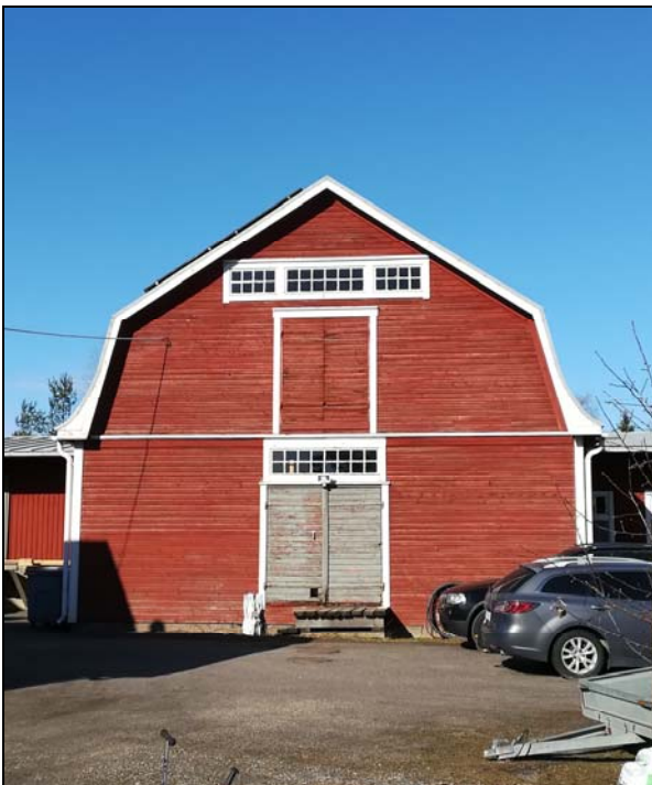
Vanha tavaramakasiini on varaston sivusiipenä.
