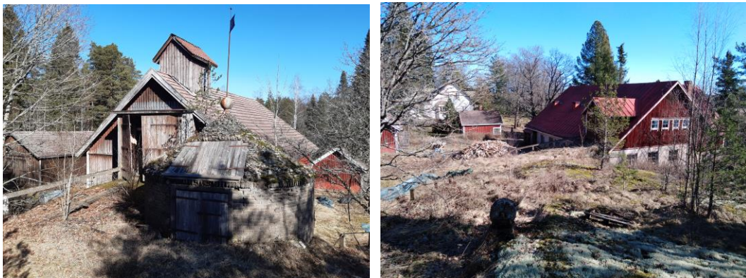
Kuva 17 Suni-Keskitalon maastonmuotoja myötäileviä talousrakennuksia.
