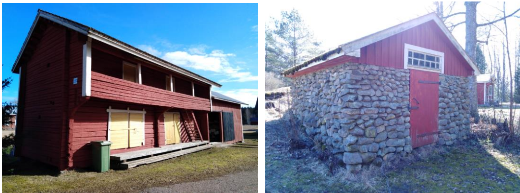
Kuva 16 Vasemmalla Nokan hirsiluhti ja oikealla Kupelan kivinen talousrakennus.
