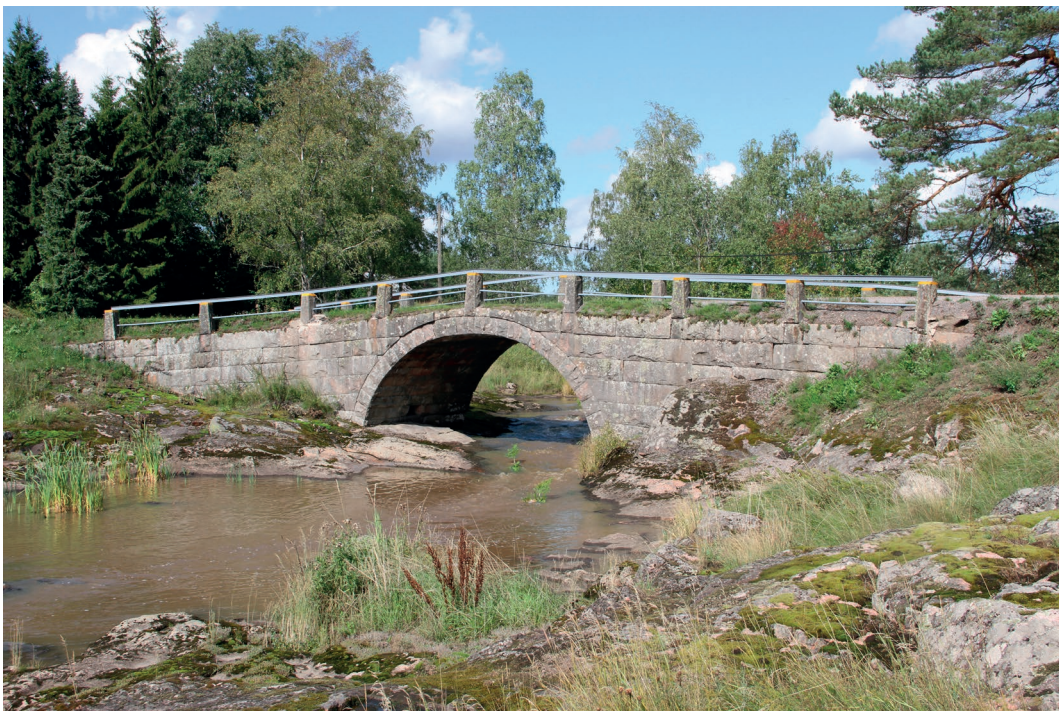
Osa-alue 8. Käyrän työsiirtolan kiviholvisilta
