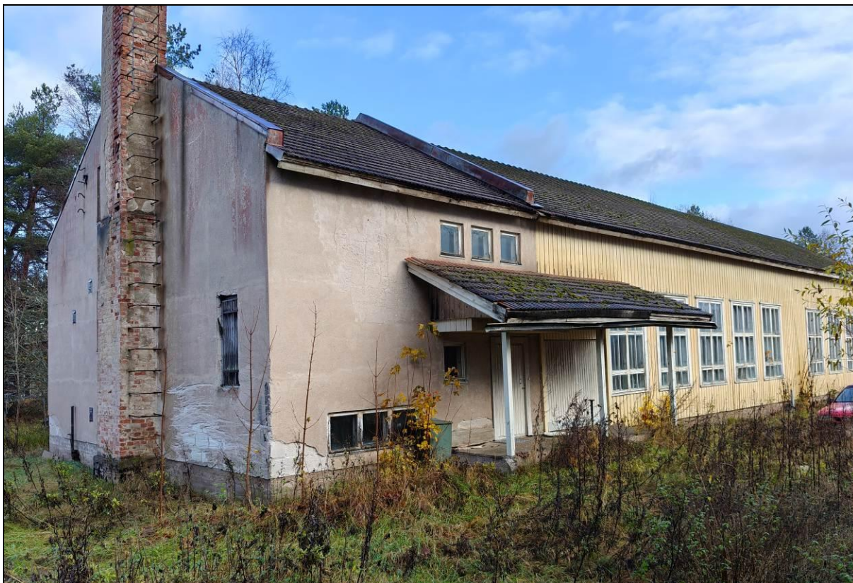
Entisen puusepäntehtaan tiilirakenteisessa osassa on tiloja kolmessa kerroksessa, sisältäen lämpökeskuksen, konttorin ja asuinhuoneiston. Sen jatkona on sisätilaltaan korkea ja kookas konesali, johon tuovat runsaasti valoa aikakaudelle tyypilliset suorakaiteen muotoiset ruudutetut ikkunat.
