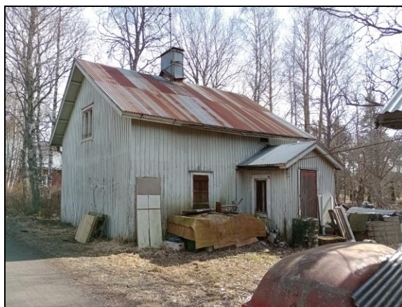
Tievarteen 1930-luvulla rakennettu talo on autiona.
