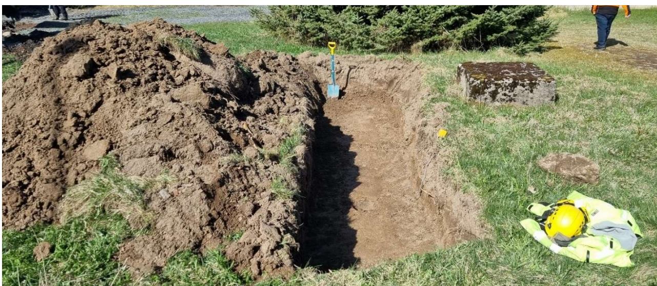
Kuva 1. Koeoja 1 kaivettuna puhtaaseen pohjamaahan. Ojan oikealla puolella näkyy vanhan rakennuksen uunin perustus. Länteen.
