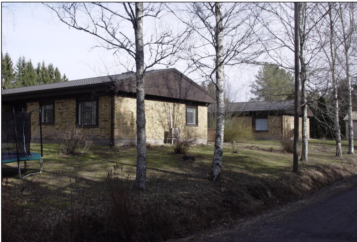
Arvinkuja on asuntoalueen kautta kulkeva, lähinnä kevyen liikenteen käytössä oleva reitti. Sen pohjoispuolella on 1980-luvun alkupuolella rakennettu neljän rivitalon ryhmä.
