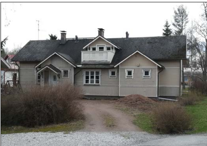
Jaakolan asuinrakennuksen (8) sisällä on vanha hirsirunko.
