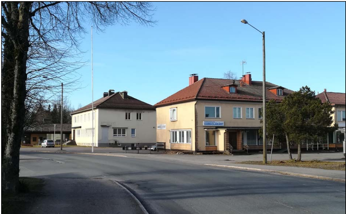
Turuntien varren vanhat pankkirakennukset muodostavat taajamakuullisesti eheän ryhmän. Liiketoille ei kuitenkaan ole enää entistä tarvetta, millä on vähitellen näkyvää vaikutusta rakennusten käyttöön ja ylläpitoon.
