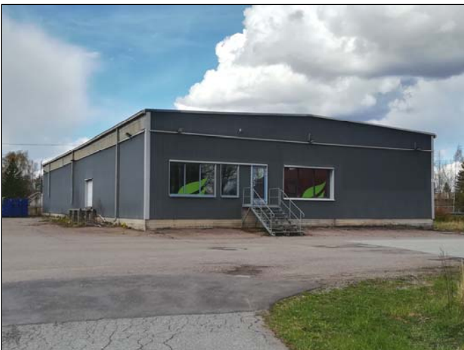
Samalla kiinteistöllä Tukola 11:0 sijaitsee lisäksi varasto-/myymälärakennus.
