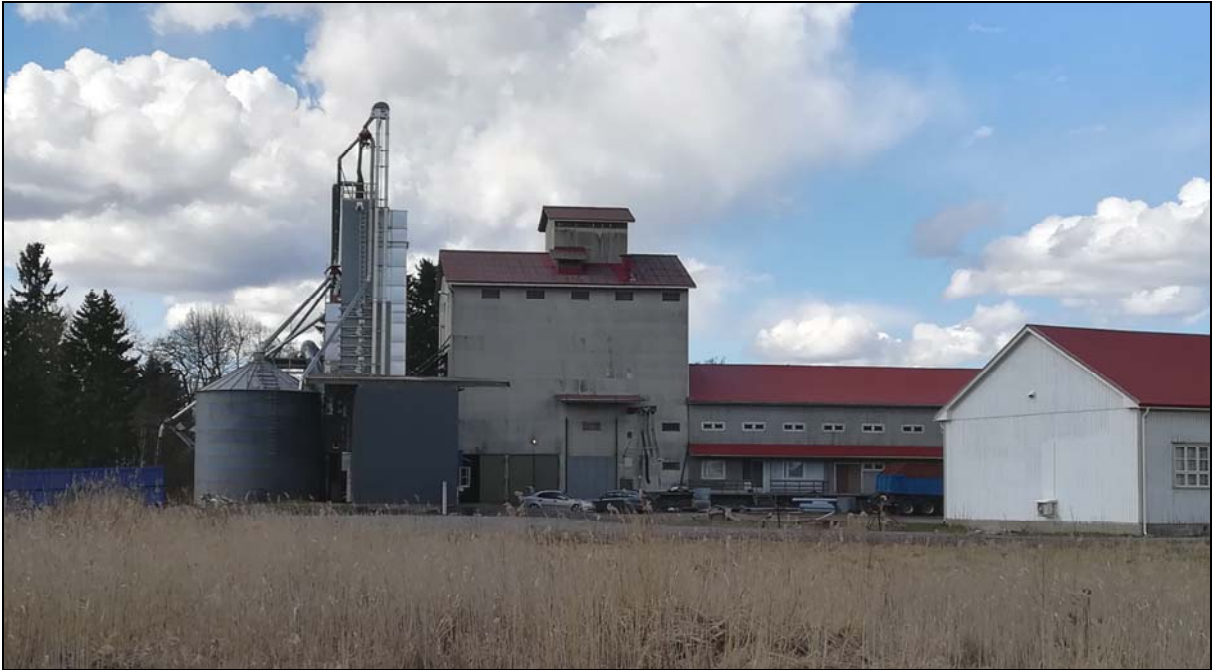
Korkea uudempi kuivuri ja siihen liittyvät metallirakenteiset viljasilot ovat myös ympäristöön näkyvä rakenteita.
