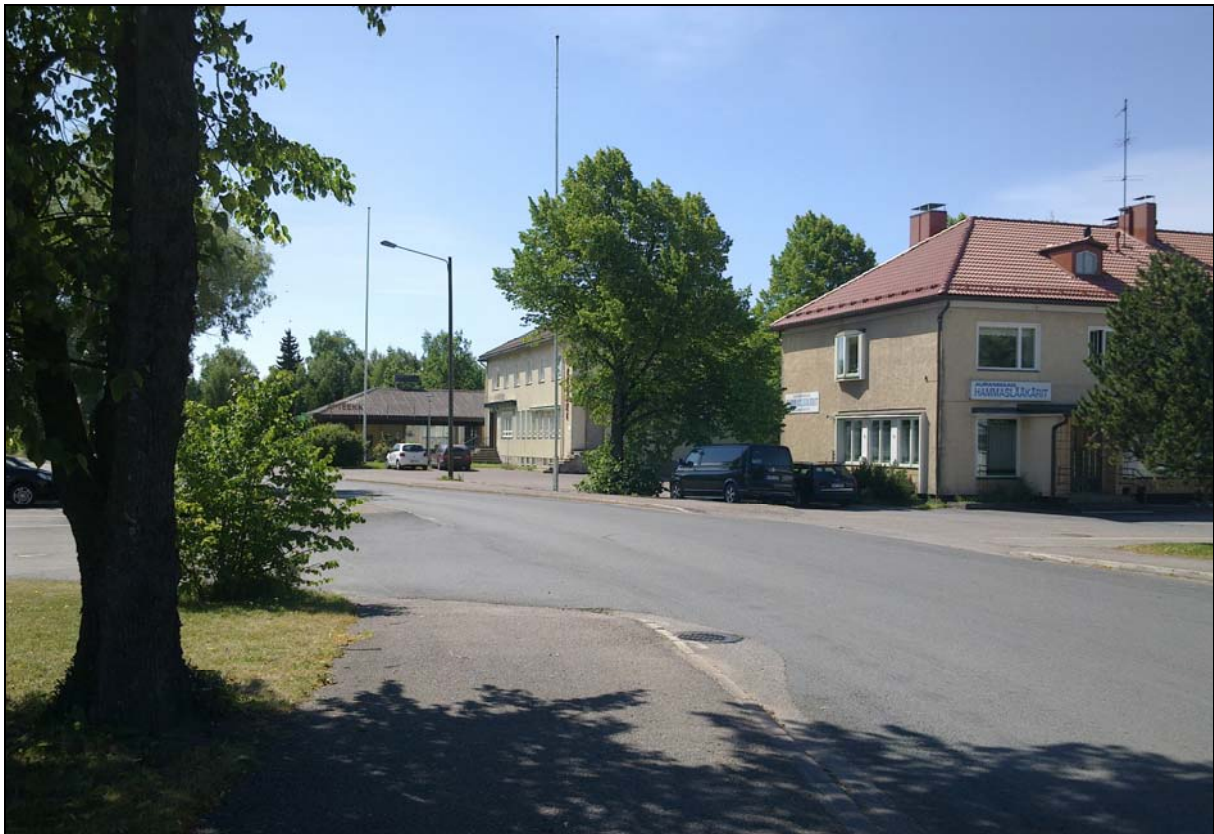
Suunnittelualueen aumakattoiset rakennukset muodostavat pienen kokonaisuuden Turuntien varteen, mutta niiden merkitys taajaman liiketoiminnan kannalta on vähitellen hiipunut.
