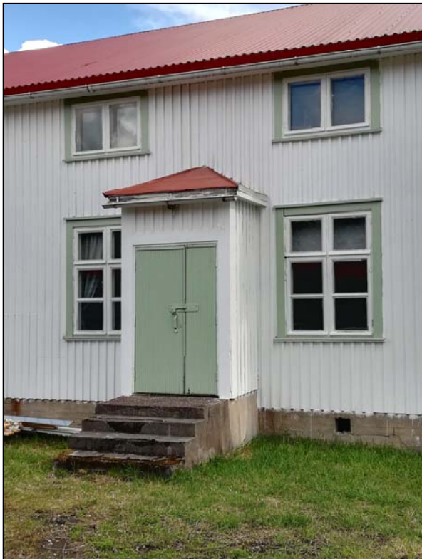
Ulokkeina tehdyt pienet kuistit ovat umpinaisia. Betonin käyttö sokkelissa ja portaissa on ajalle tyypillistä, kuten vuorauksen peiterimalaudoituskkin.
